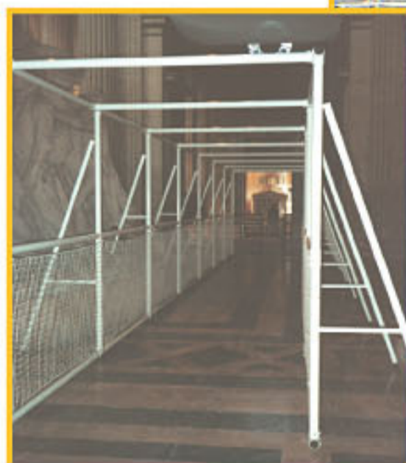
Tunnel blindé au Panthéon à Paris.
