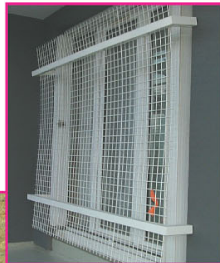
Barrière de sécurité lors de rénovation de balcons.
